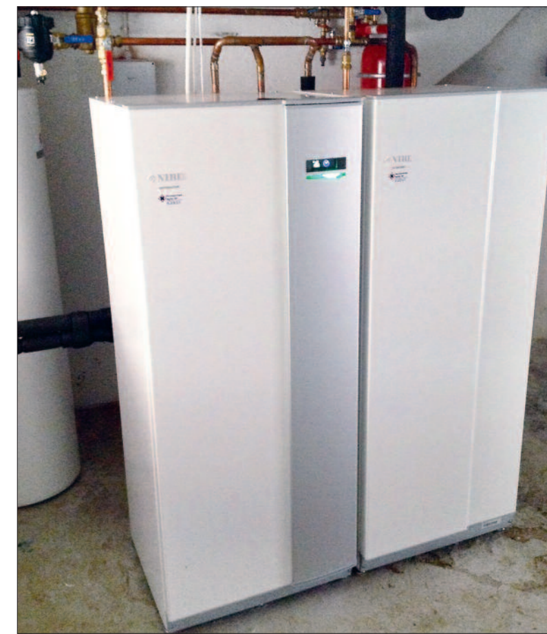
Den gamle oljefyren hos Oland fra Grimstad ble erstattet med en NIBE 10 kW bergvarmepumpe.
